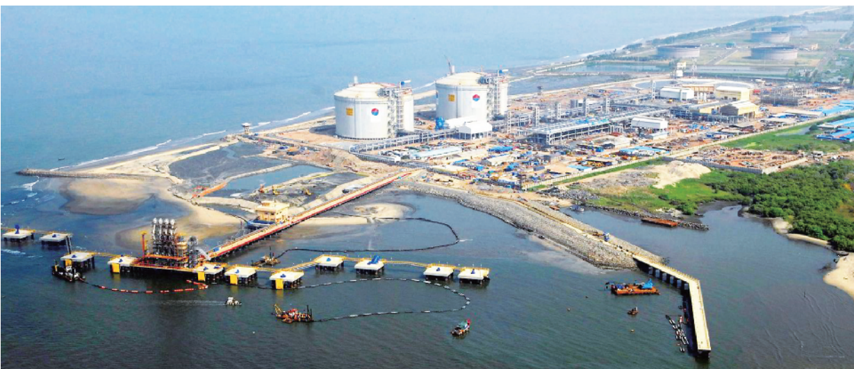
图为印度东海岸近海正在修建一座新的LNG进口终端。
