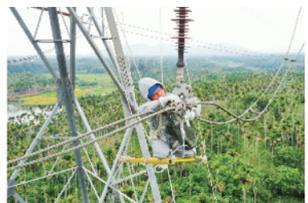
图为南方电网海南输电运检分公司带电作业中心对万宁220千伏红牵I线开展带电自主检修工作,保障迎峰度夏期间线路稳定运行。 张运娇/摄
