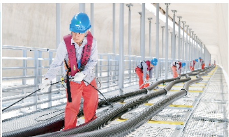
5月13日,电缆检修人员在舟岱大桥钢平台检查随桥电缆中间接头处电缆附件情况。张道历/摄
