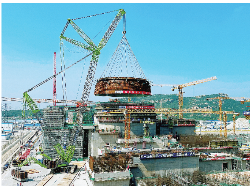
图为吊装中的田湾核电站7号机组穹顶球带。 杨立原/摄
