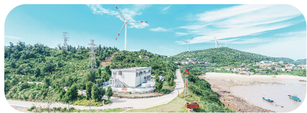
图为世界首个柔性低频输电示范工程35千伏大陈变电站和低频风机现场。国网台州供电公司/供图
