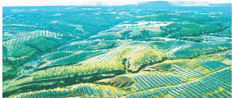
图为山西新荣采用隆基绿能产品建设的光伏发电项目。
