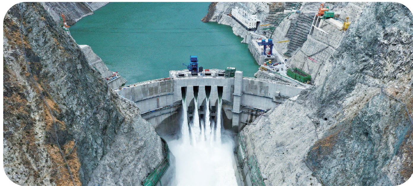
图为雅砻江杨房沟水电站大坝
