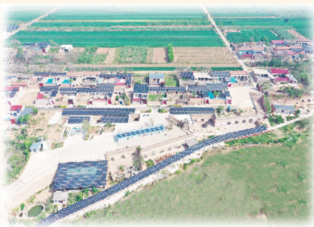
图为装满光伏板后的庄上村全景。国网山西省电力公司/供图
