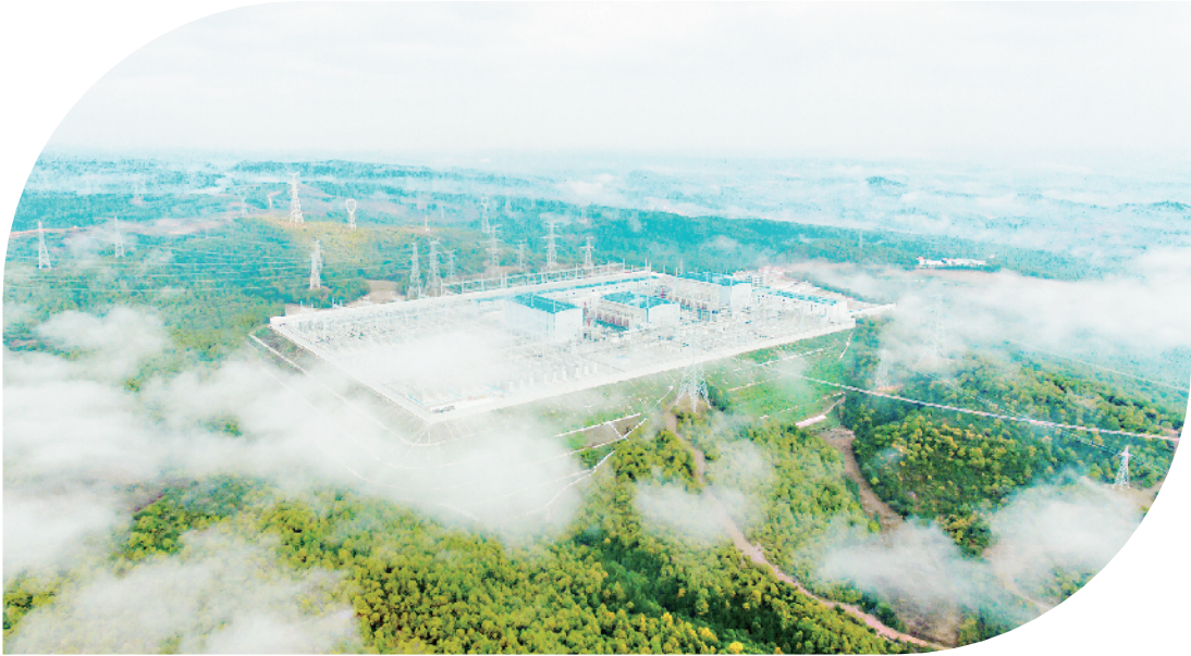
昆柳龙直流工程将西部地区的清洁能源持续不断输送至粤港澳大湾区。图为昆柳龙直流工程北流站。
