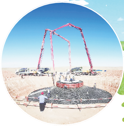
京能查干淖尔电厂风光火储氢示范项目首台风机浇筑
