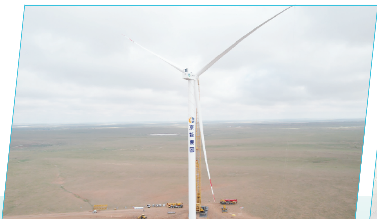
京能查干淖尔电厂风光火储氢示范项目苏左500MW风电项目首台风机吊装
