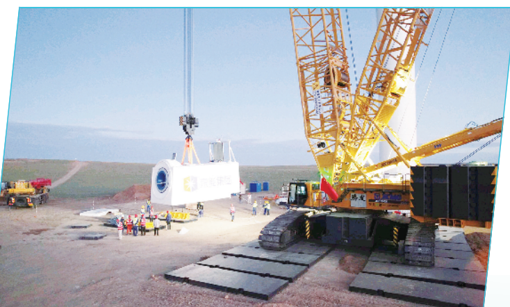
京能清洁能源内蒙古分公司苏左项目首台风机吊装
