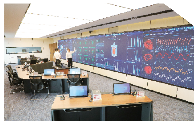
南网储能公司员工研讨平台功能优化方案。南网储能修试公司/图
