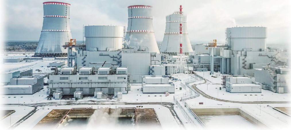
图为匈牙利保克什核电站。俄罗斯原子能公司负责该电站扩建工作。
