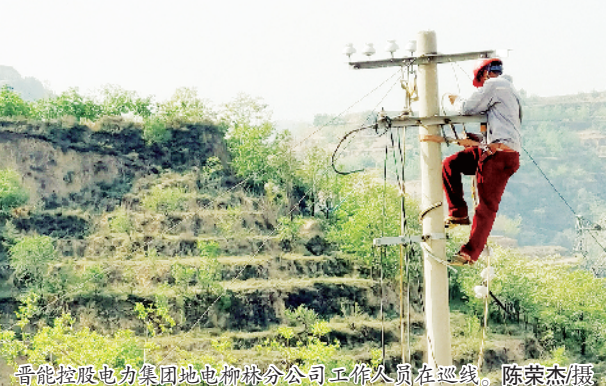
晋能控股电力集团地电柳林分公司工作人员在巡线。陈荣杰/摄
