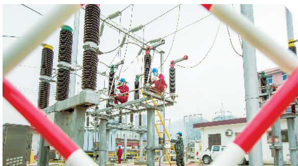
晋能控股电力集团地电乡宁分公司在检修线路。赵玉虎/摄
