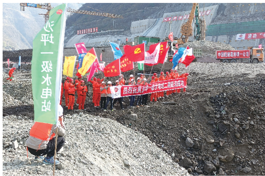
沙坪一级水电站二期工程截流成功
