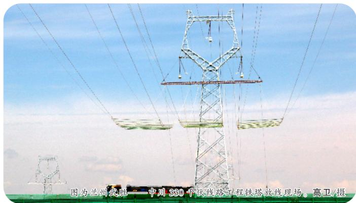
图为兰州供电一申则330千伏线路工程铁塔放线现场。高卫/摄
