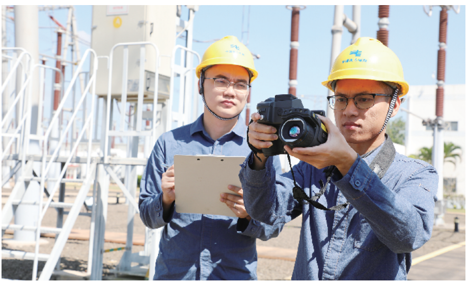
南网超高压公司海口分局运维员工对福山变电站设备进行巡视维护。吴玉转/摄
