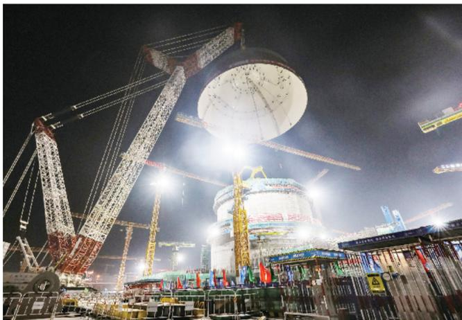
本报讯 2月21日，“十四五”我国首个开工核电项目、海南最大能源投资项目——华能海南昌江核电二期3号机组内穹顶吊装就位，标志着该机组从土建施工阶段全面转入安装阶段。
