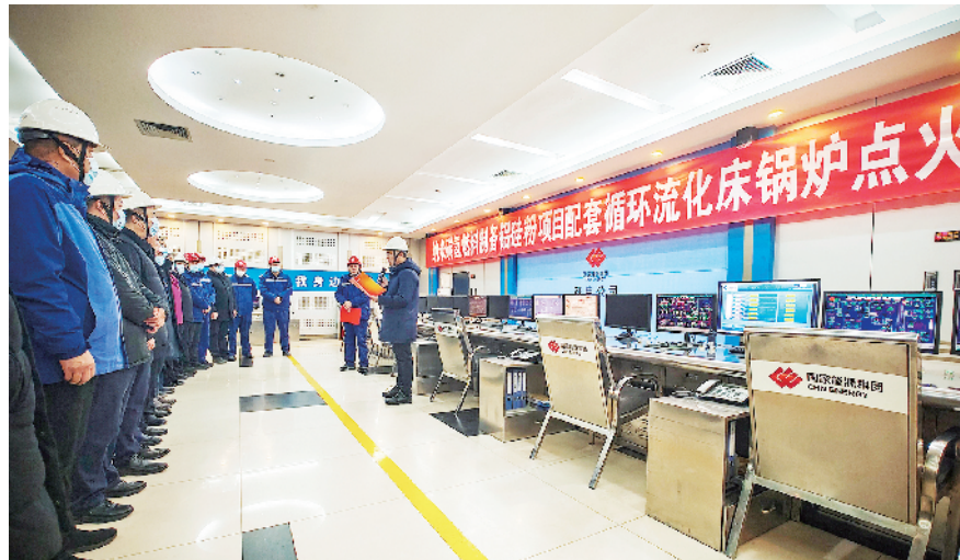
图为纳米碳氢燃料制备铝硅粉项目配套循环流化床锅炉点火启动仪式 王国灏/图
