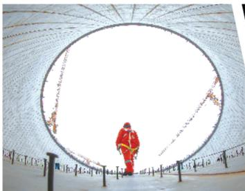
施工人员进行储罐升顶前最终检查。中国海油/图
