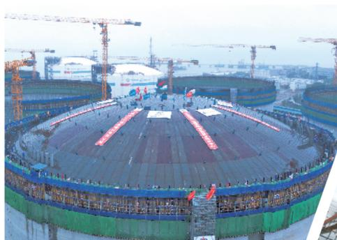
粤港澳大湾区首座27万立方米液化天然气储罐成功升顶。中国海油/图
