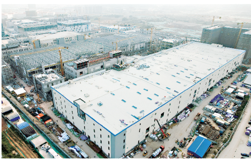
海辰储能正在建设中的M2和M3智慧工厂
