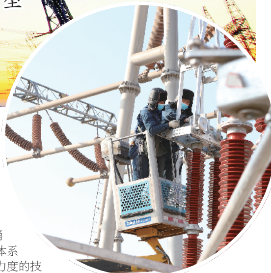
2022年12月9日,石嘴山公司扩建兰山变220千伏母线间隔,备战包银高铁接入。 韩霜/摄
