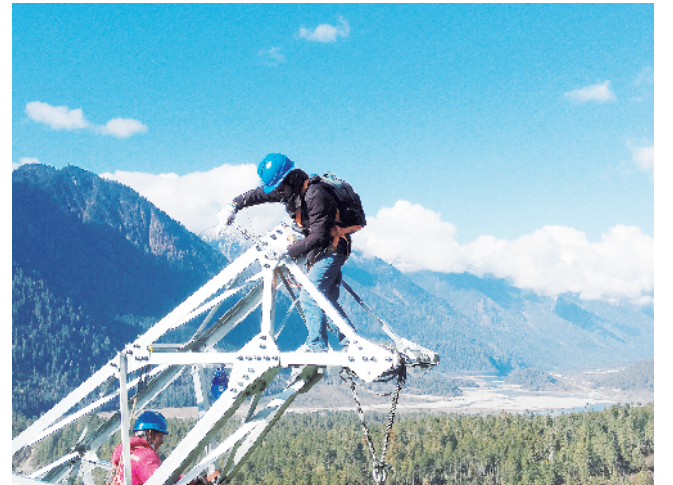
在波林1线倒塔现场开展杆塔螺栓紧固率抽样检查。
