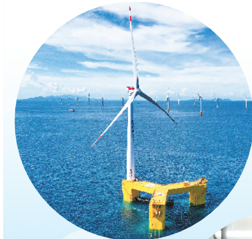
2021年12月7日，明阳智能全球首台抗台风型漂浮式海上风电机组在三峡阳江沙扒海上风电场投运。
