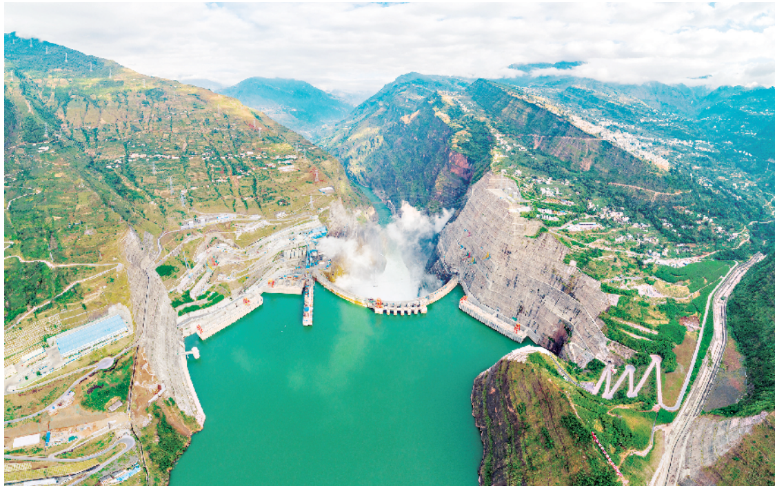
航拍白鹤滩水电站。三峡集团/供图
