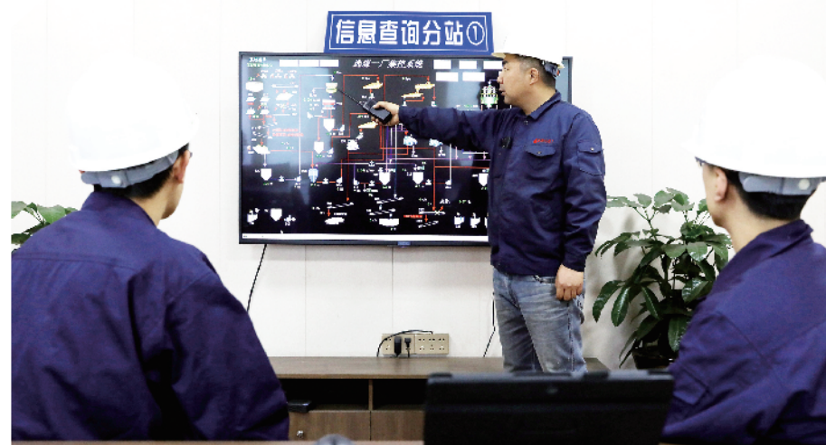
图为柳湾煤矿智能化选煤厂职工正在通过信息查询分站了解各设备运行情况
