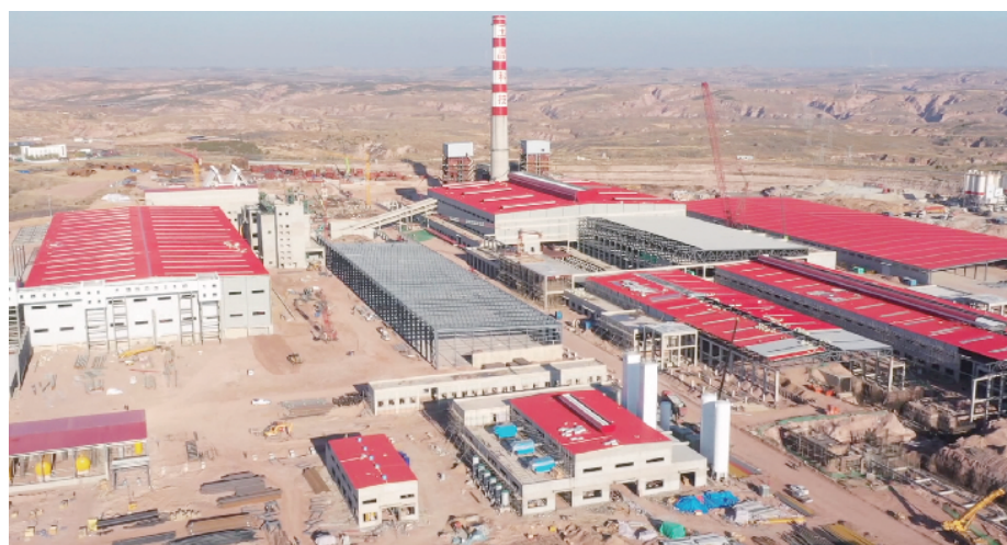
位于内蒙古准格尔经济开发区的总投资80亿元的玉晶科技优质特种玻璃综合利用一体化项目一期工程建设接近尾声 王丽曼/摄
