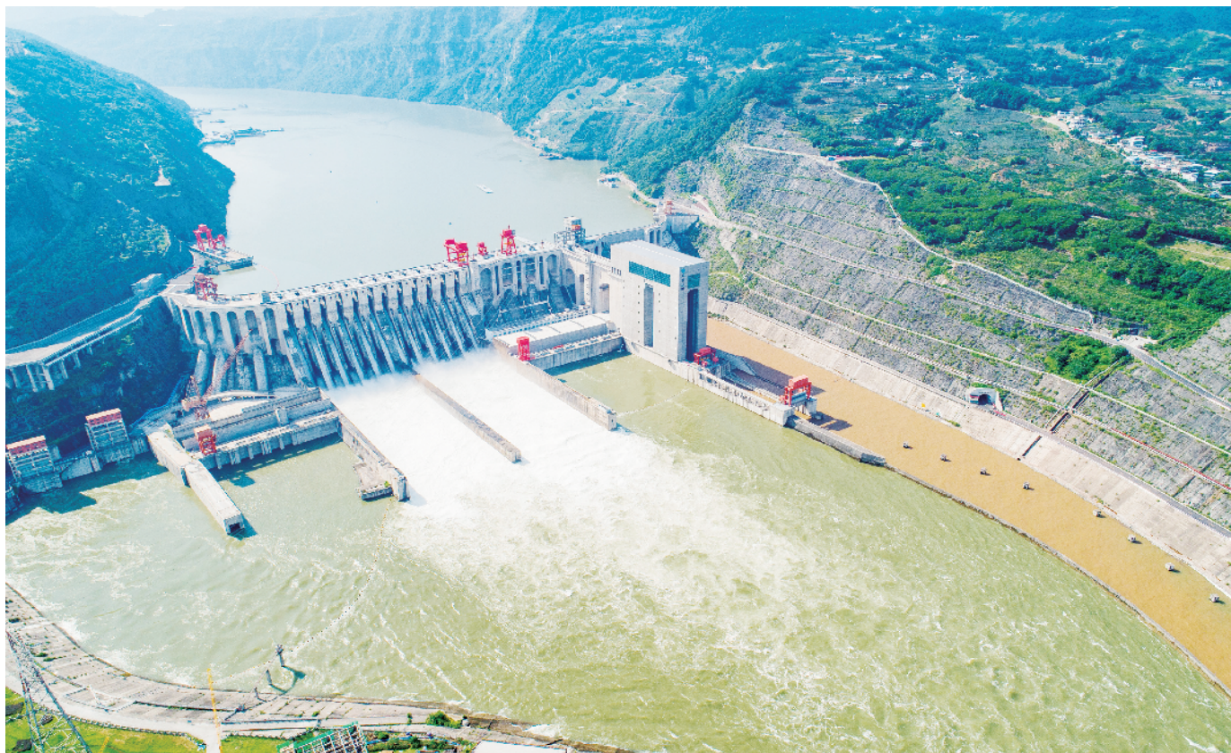
清洁水电是能源企业低碳转型的重要方向之一，图为向家坝水电站大坝上下游全景航拍。三峡集团/供图
