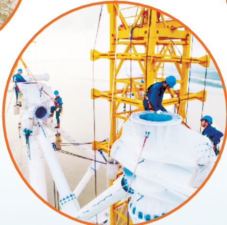
204米高的东洲-崇明500千伏线路工程(上海段)K1跨越塔组立阶段。 黄海/摄
