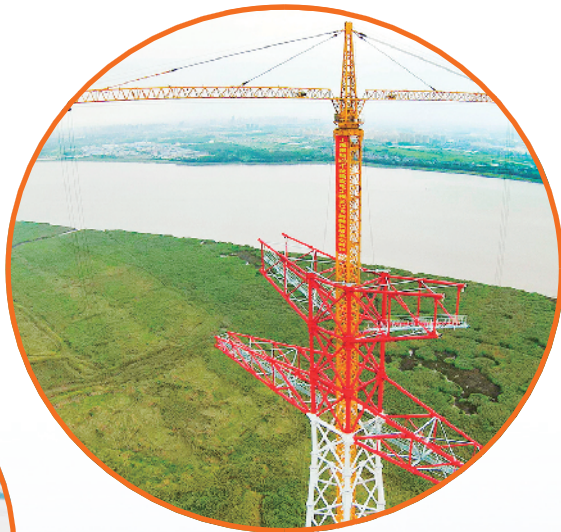
204米高的东洲-崇明500千伏线路工程(上海段)K1跨越塔封顶。 张秉钧/摄
