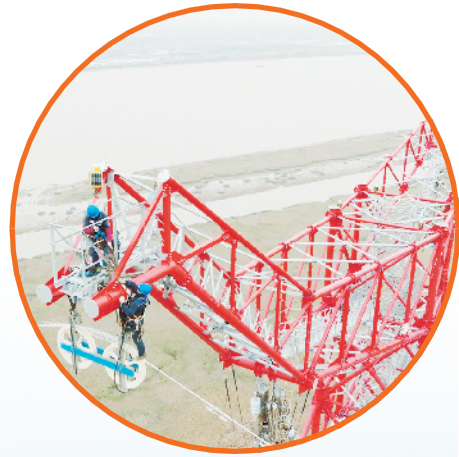
东洲-崇明500千伏线路工程(上海段)长江大跨越段上海送变电工程有限公司的施工人员在跨越塔上进行附件安装作业。 庄侃/摄
