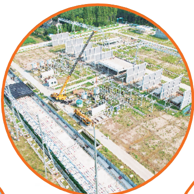
崇明500千伏输变电新建工程现场进行电抗器吊装。 沈棋棋/摄
