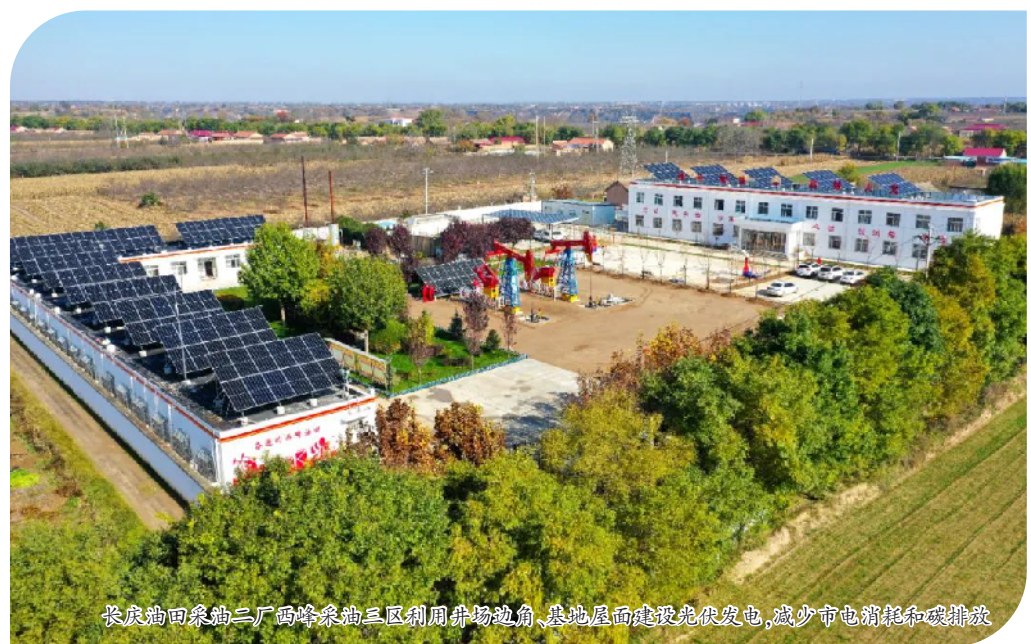
吉林油田供电公司员工维护光伏板
