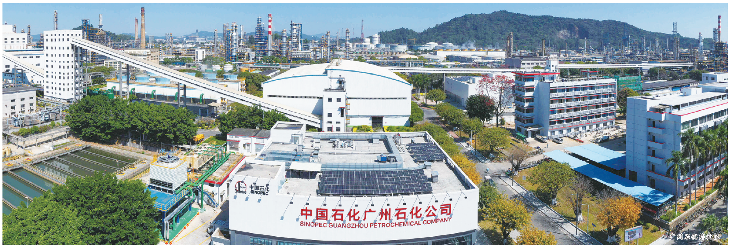
广州石化氢燃料电池供氢中心
