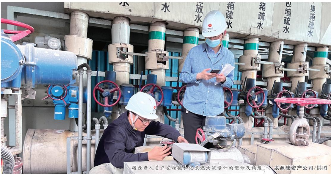
碳盘查人员正在拍摄记录燃油流量计的型号及精度。龙源碳资产公司/供图
