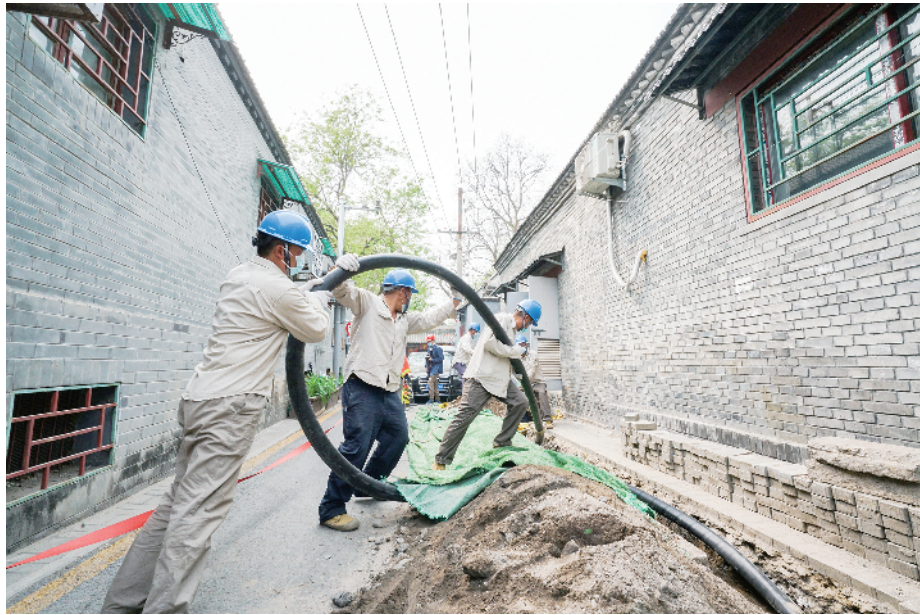
国网北京城区供电公司服务“非禁免批+投资到红线”典型案例施工作业现场。梁静/摄
