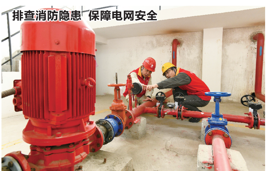
日前,国网江津区供电公司员工对220千伏龙井变电站开展消防安全检查和隐患排查,有效预防火灾事故的发生,确保电网安全稳定运行。通过消防安全检查,进一步强化了消防安全责任制的落实,深化了安全隐患的排查整改,有效预防火灾事故的发生,营造出安全生产的良好环境。图为安全检查现场。王化全/图文
