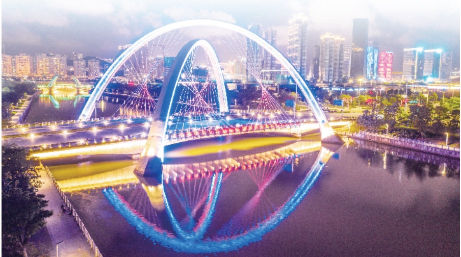
南方电网通过推进配电网架和自动化建设工作，为横琴粤澳深度合作区供电可靠性提升提供了有力支撑，目前横琴粤澳深度合作区供电可靠性已达到世界一流水平。周卓英/摄
