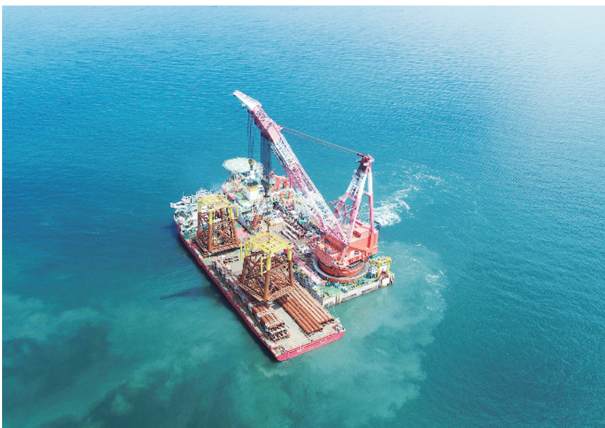
垦利6-1油田最大区块生产平台导管架吊装作业现场。中国海油/供图
