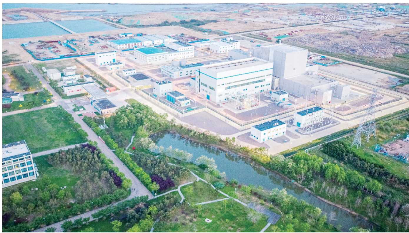
位于山东荣成石岛湾核电基地的全球首座球床模块式高温气冷堆核电站示范工程。中国核电/供图
