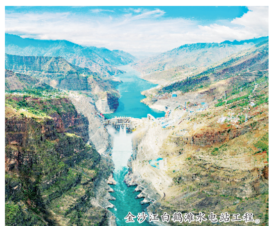
金沙江白鹤滩水电站工程。
