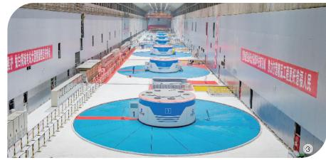
2022年9月22日,随着8号机组完成72小时试运行,金沙江白鹤滩水电站左岸全部8台机组投产。至此,东方电气集团白鹤滩项目研发制造、安装服务任务圆满收官。白鹤滩机组核心部件采用数字化智能制造,产品质效大幅提升;机组转动部件重达2600吨,由上万个零部件构成,实现了"零配重";机组稳定性好,摆度仅一根头发丝直径大小;发电机温升控制水平高,开创巨型水电机组新纪元;水轮机最优效率达96.7%,发电机额定效率超过99%,处行业领先地位。
