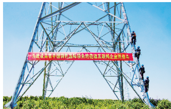
大连500千伏登台输变电工程的施工照。王帅/摄
