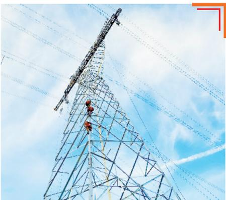
辽宁省送变电工程公司开展220kV红黄线停电改造任务。赵华松/摄
