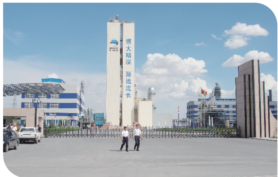
博源联化100万吨天然气制甲醇项目
