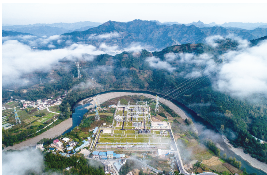
南方电网首座500千伏数字化GIS变电站——贵州电网铜仁供电局500千伏碧江变电站。 陈涛/摄
