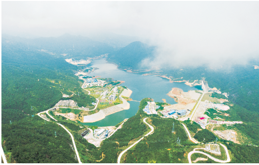
南方电网梅州抽水蓄能电站二期工程下库。陈志军/摄
