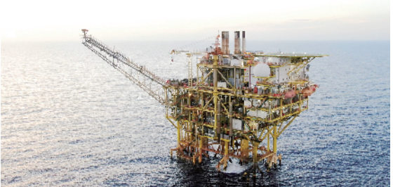
位于莺歌海的乐东气田中心平台,与国产深水水下生产系统通关缆连接,能够远程监测水下生产系统运行情况并控制水下气井生产状态。
