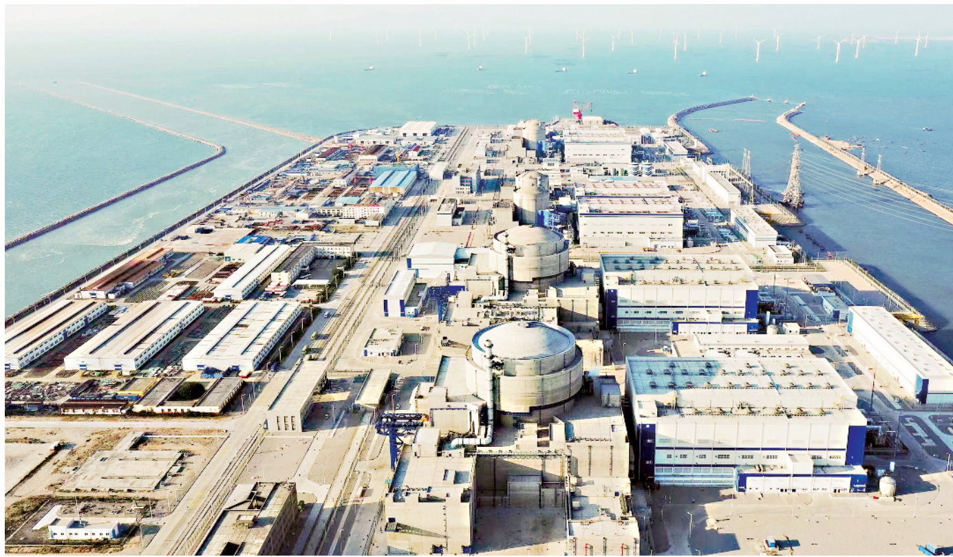
图为“华龙一号”项目现场 中核集团/供图
