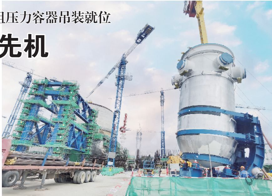
漳州核电2号机组压力容器吊装现场。中核集团/图
