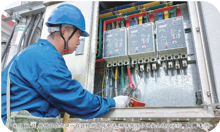
8月11日,韩树旺在岔口一区检测负荷电流,确保低压台区安全稳定运行。何腾飞/摄
