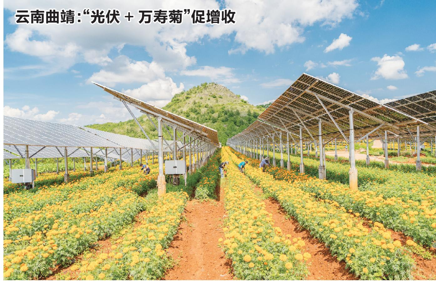
云南曲靖沾益区菱角乡农业光伏发电项目将太阳能光伏组件铺设在农作物之上,形成“上面发电、下面种植、科学开发、综合利用”的“农光互补”建设模式。
