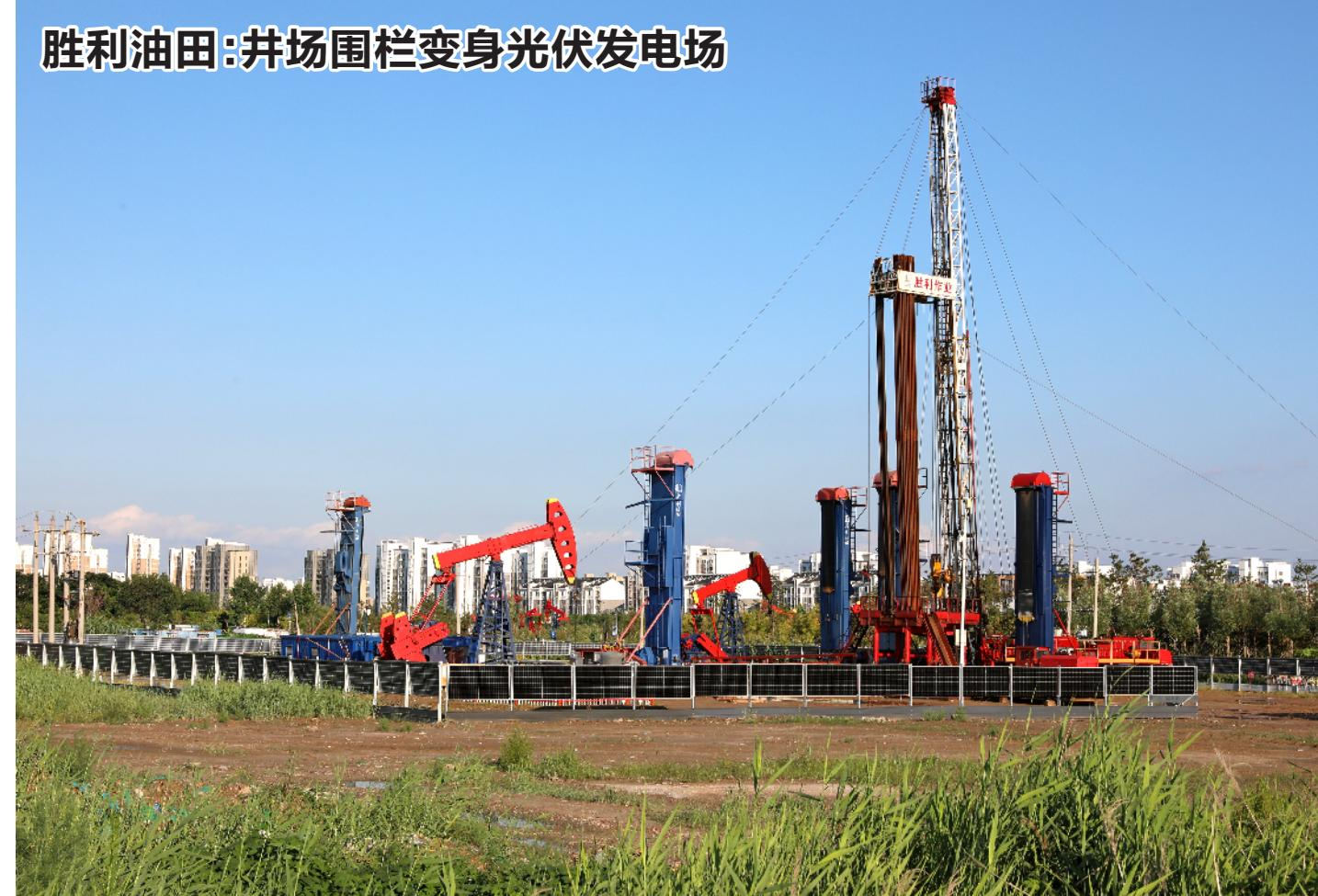
近期,胜利油田在充分论证土地资源、合作模式和供电技术的基础上,将井场的传统围栏替换成能发电的双面光伏围栏,实现了光伏绿电、智能群控和零散土地利用的叠加式创效。目前,该油田已建成井场光伏围栏项目1个,正在建设3个,另有11个进入可研方案编制,预计全部投产后年均发电量可达986万千瓦时。
