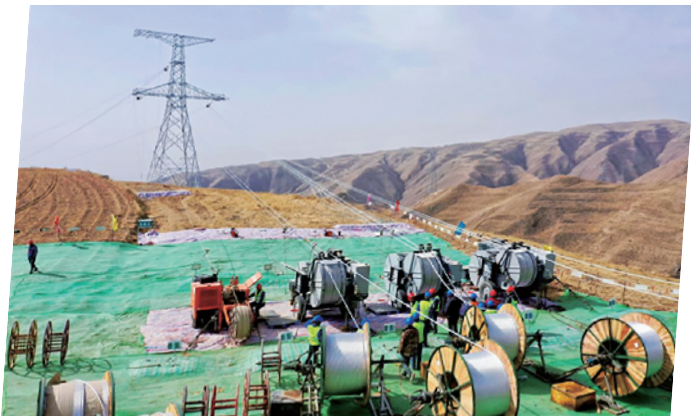
郭隆-武胜第三回 750 千伏输电线路工程(青海段)首场架线施工现场。 邹建华/摄
